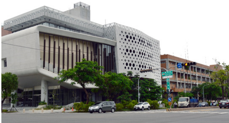
水利系新舊大樓並列，左側為新建之海工大樓外觀（董東璟攝）
