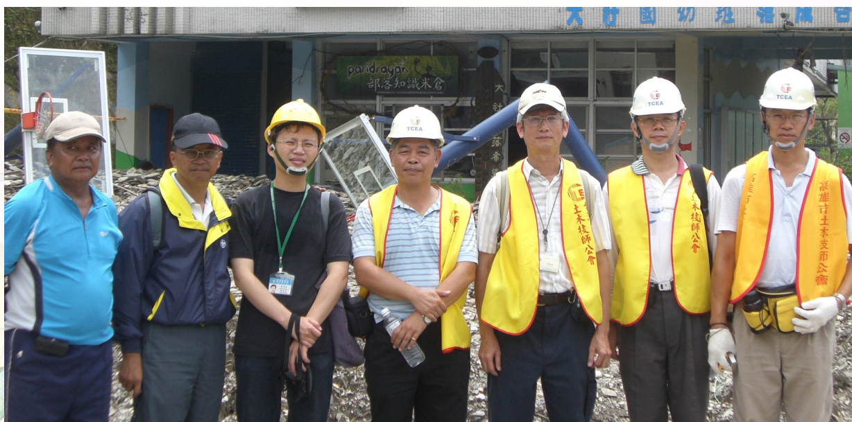
洪觀英學長（右三）提供的在921大地震後土木技師公會災後現勘情形
